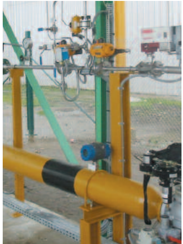
Biogas, eine Mischung aus Methan und Kohlendioxid, entsteht beim Abbau organischer Materialien und kann als Energiequelle genutzt werden. Aufgrund seiner „Low Flow“-Empfindlichkeit und des geringen Druckabfalls ist der TA2 ein ausgezeichnete Durchflussmesser zur Messung für Biogase.
